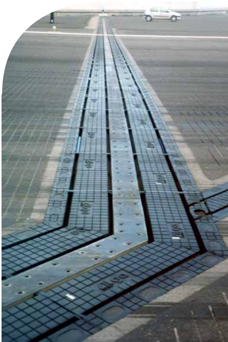
Giunto Algaflex TX installato. Stoccaggio. Algaflex TX expansion joint installed. Storage.
