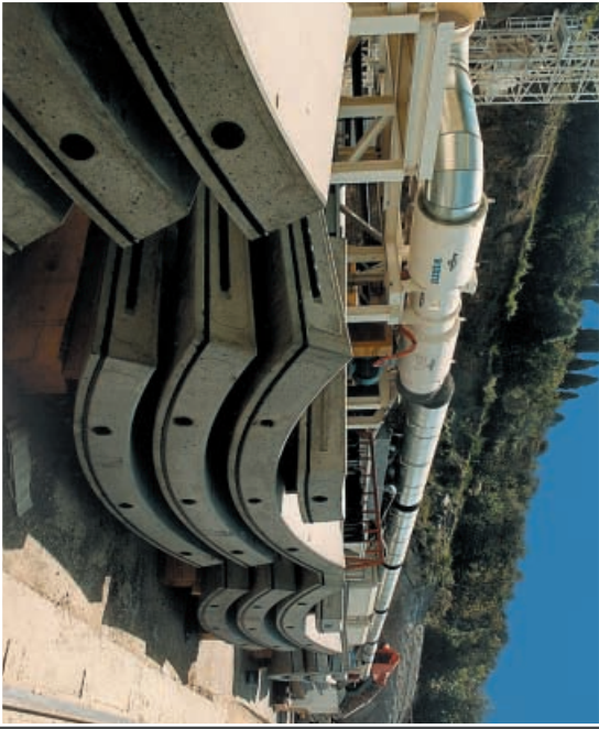
• TRENO AD ALTA VELOCITÀ - ITALIA sistema di connessione conci, guarnizioni, barre guida e adesivo
