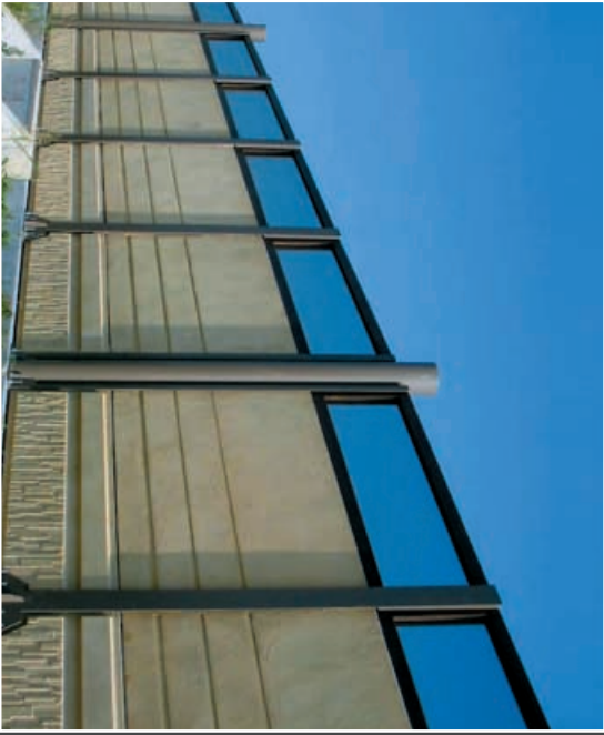
• LINEA FERROVIARIA PD-VE - ITALIA barriera antirumore con struttura portante in acciaio zincato e pannelli in calcestruzzo e PMMA montati su telaio ligneo
