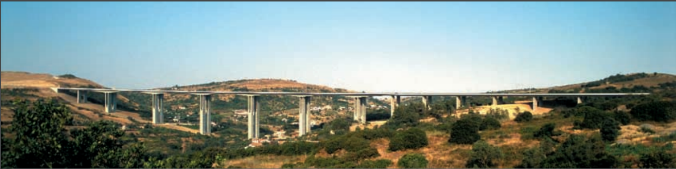
PORTUGAL - Loureiro Viaduct
