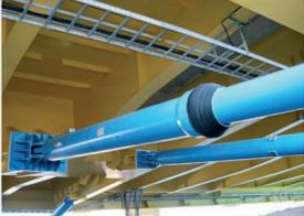
Un dispositivo della serie SR installato assieme a dissipatori viscosi nel Rion Antirion Bridge (Grecia).
