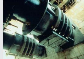
Dispositivi NE installati nel Viadotto Somplago, il primo ponte europeo sismicamente isolato (1974-1976).
