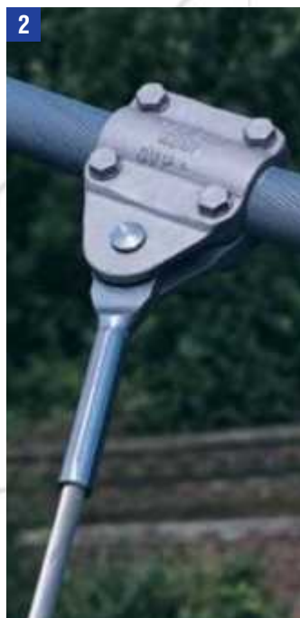
Anschluss Hängerseil an Tragseil Connection of hanger cable to suspension cable
