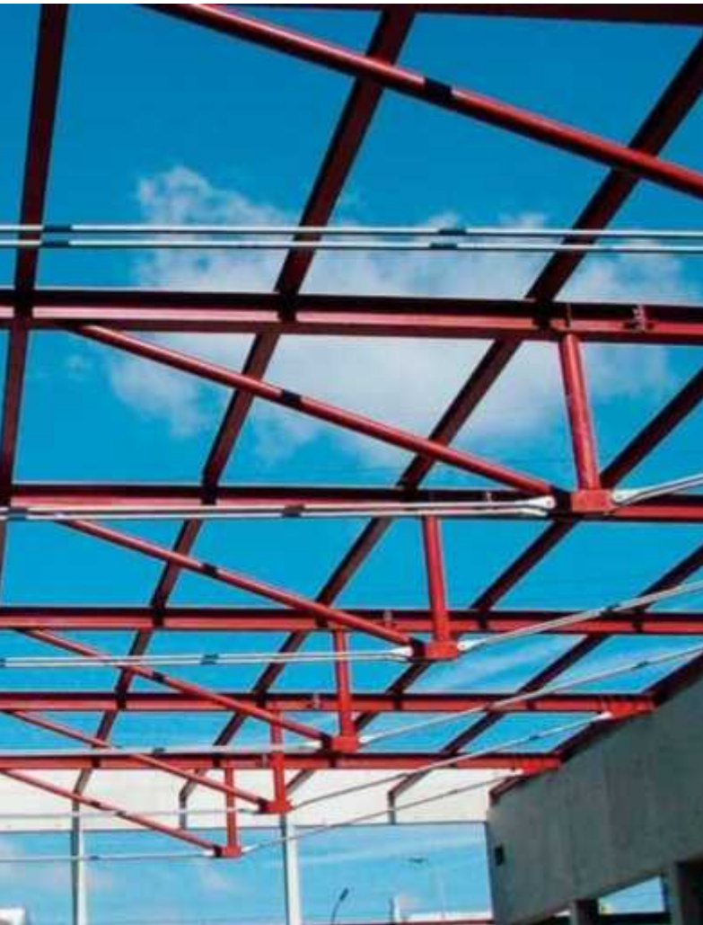
Abhängung an einem Stab / an einer Muffe Suspension of the bar / at the coupler
