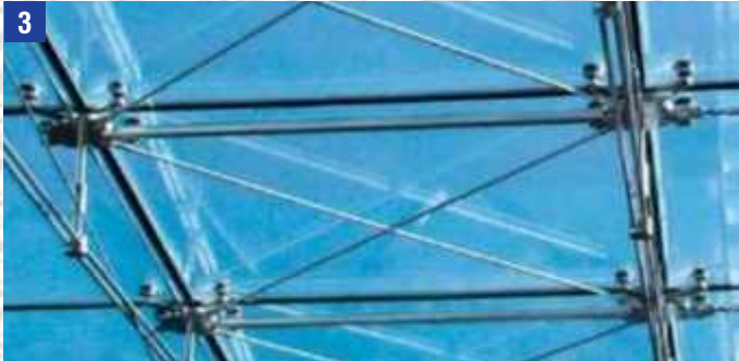
Anschluss Druckstütze an Doppelseilnetz Connection of compression strut to parallel cable net
