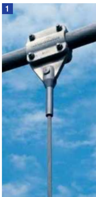
Anschluss Hängerseil an Tragseil Connecting hanger cable to suspension cable
