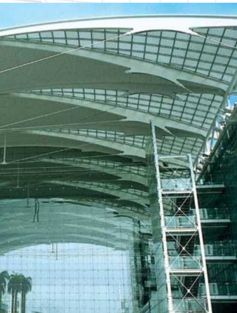
Anschluss Spannseil an Rahmen- konstruktion Connection of stabilising cable to frame
