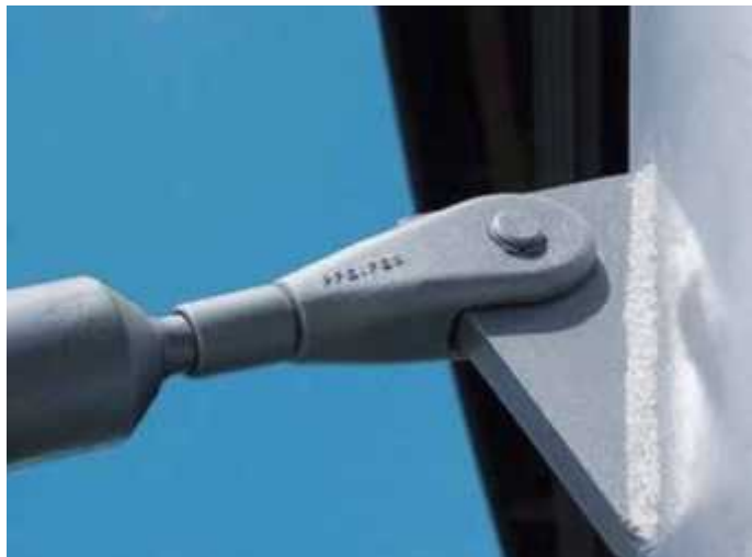
Zugelassener Druckstabanschluss Approved compression rod connector
