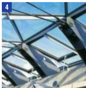
Anschluss Spannseil an Rahmen- konstruktion Connection of stabilising cable to frame
